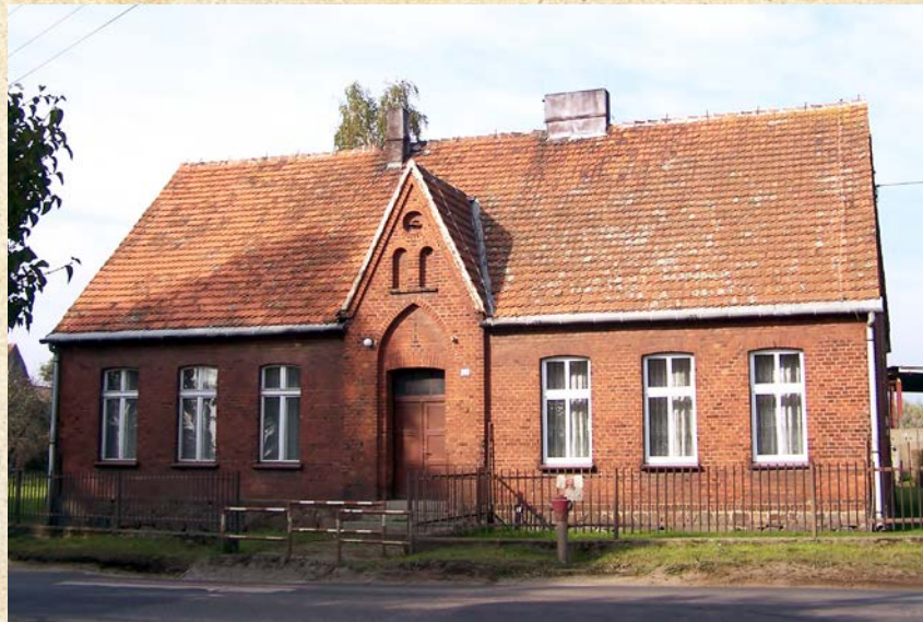
Budynek szkoły w Zalasewie z 1888 r. Stan w 2017 r. (fot. Antoni Kobza)
