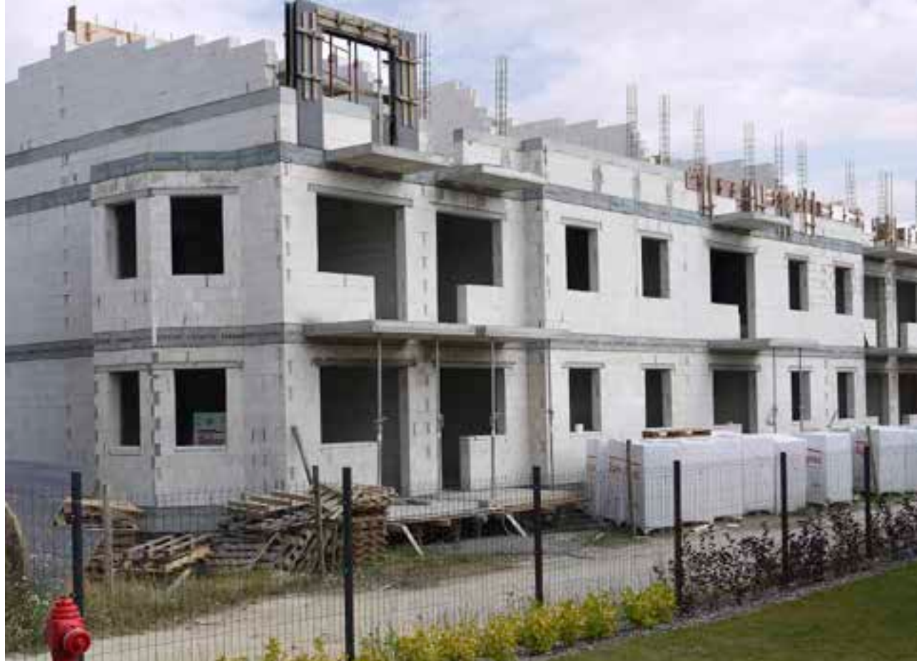
Budynek komunalny – 21 nowych mieszkań W Jasinie przy ul. Wrzesińskiej, obok oddanego do użytku w ubiegłym roku budynku z 27 mieszkaniami komunalnymi i socjalnymi, powstaje drugi, w którym zaprojektowano 21 mieszkań. Prace postępują zgodnie z planem, a na zdjęciu pokazujemy plac budowy uwieczniony w połowie lipca, gdy zamykaliśmy to wydanie „Prosto z Ratusza”.
