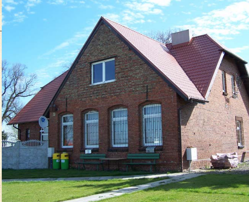
Szkoła w Sarbinowie, budynek z 1910 r. Stan w 2020 r. (fot. Antoni Kobza)
