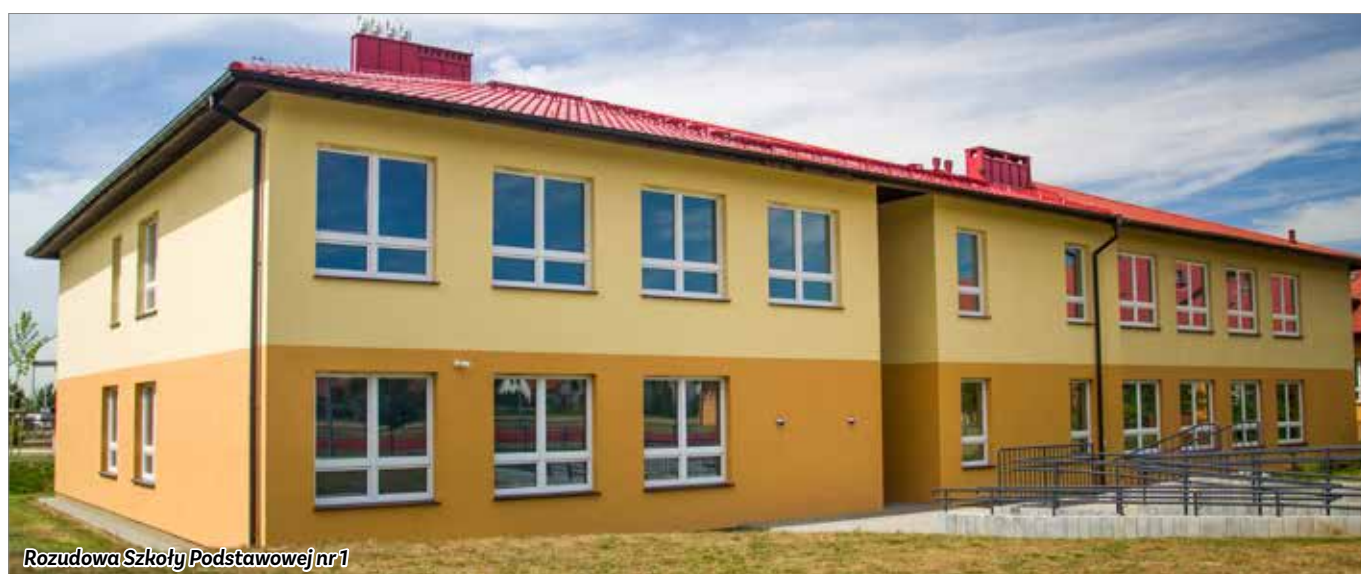
Budowa Szkoły Podstawowej nr 2
