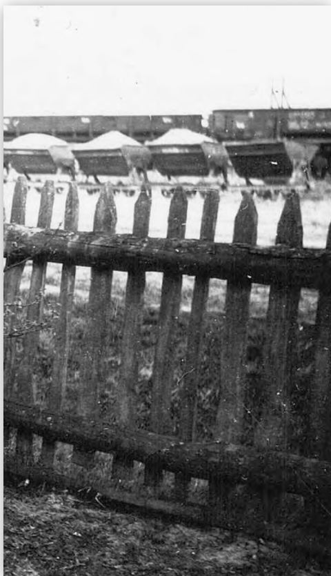
Bocznicą kolejową z wagonikami do przewożenia żwiru. Fot. ze zbiorów autorki.
